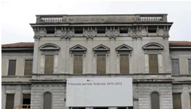
Bau des neuen Bundesstrafgerichts in Bellinzona: Werden hier künftig auch Insiderdelikte untersucht? (Bild: KEYSTONE / Karl Mathis)
