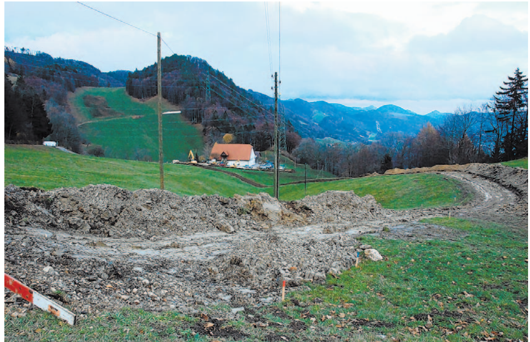
Blick auf die Untere Tannmatt, mit der Trasseeführung der neuen Wasser- und Abwasserleitungen von der Oberen auf die Untere Tannmatt. HANS A. GASSLER
